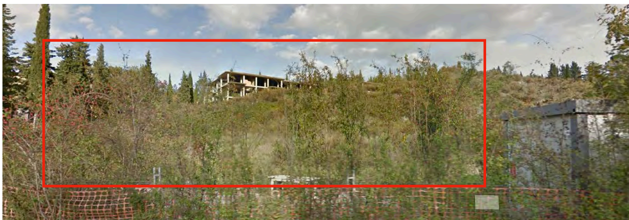
IC2.3, veduta dalla strada Provinciale n. 3 (fonte Google Street View)
