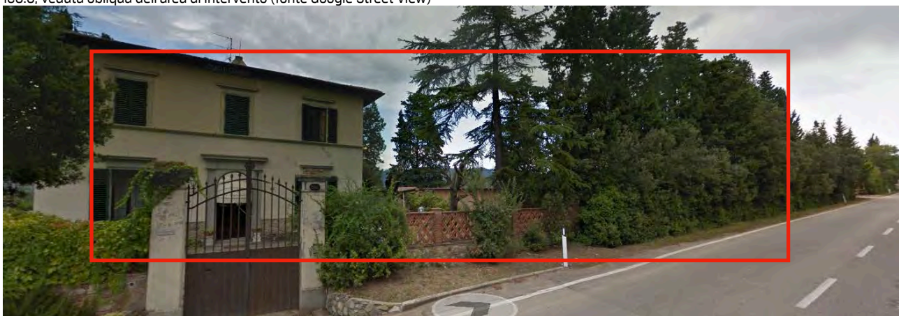
IC3.3, veduta da via Mario Rossi da nord (fonte Google Street View)
