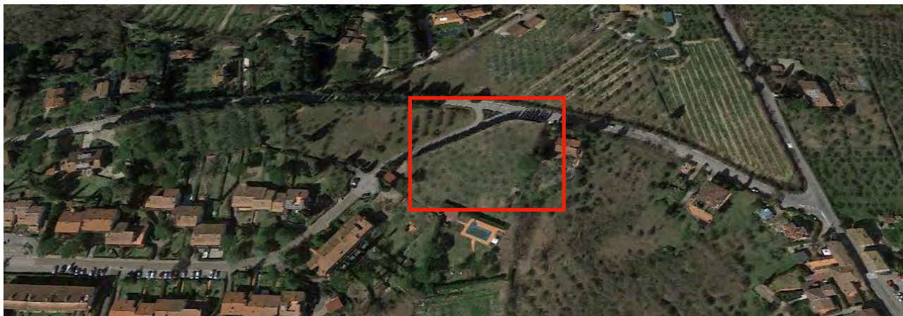
IC3.4, veduta obliqua dell'area di intervento (fonte Google Street View)
