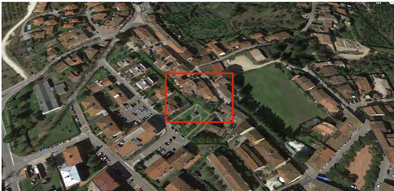
IC13.8, veduta obliqua dell'area di intervento (fonte Google Street View)
