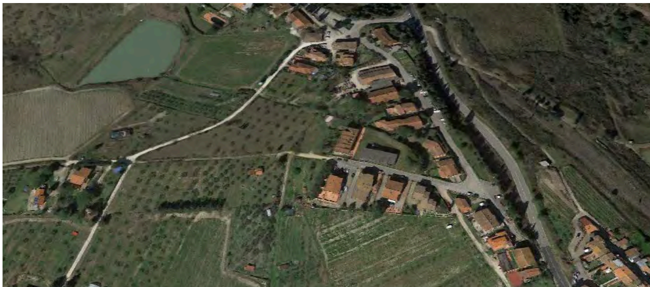
IC13.14, veduta obliqua dell'area di intervento (fonte Google Street View)
