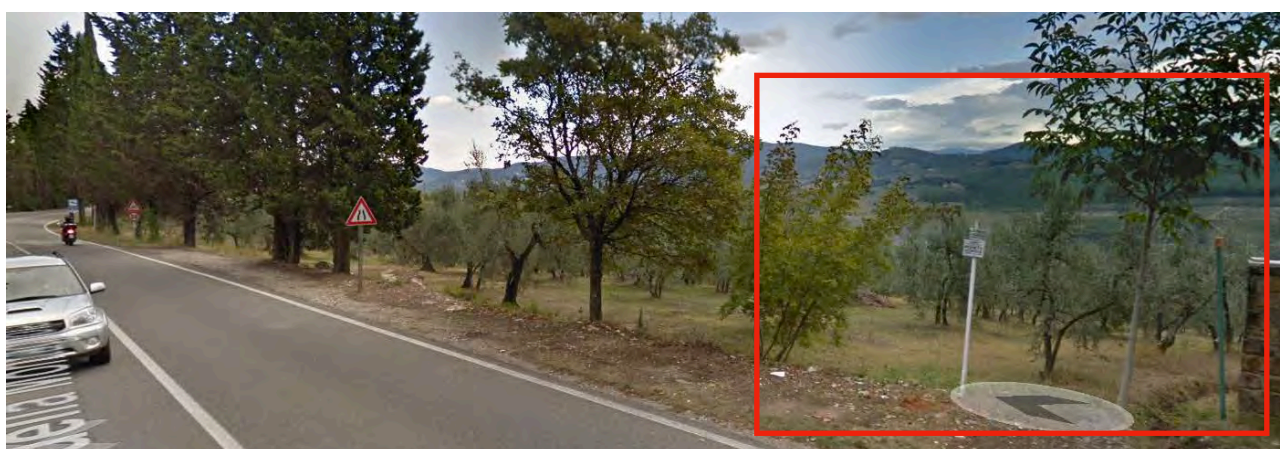
IC 3.17, veduta da nord da Via della Montagnola verso l'area interessata dalla nuova edificazione (fonte Google Street View)
