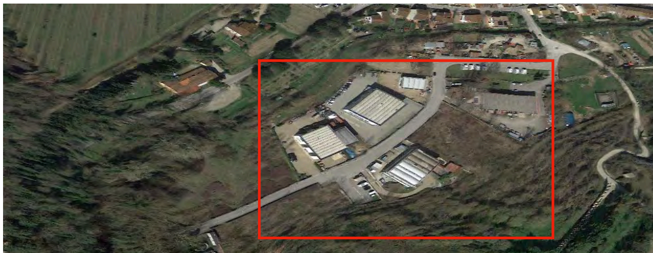
IC 4.7, veduta obliqua dell'area di intervento da sud (fonte Google Street View)
