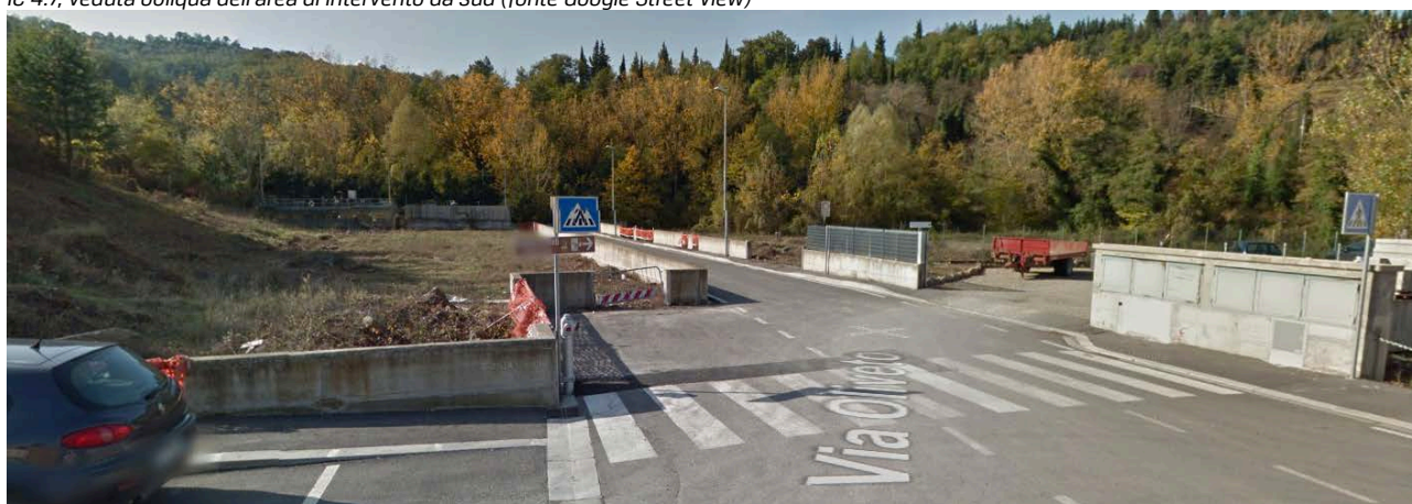
IC 4.7, veduta da nord-1 da Via Oliveto (fonte Google Street View)
