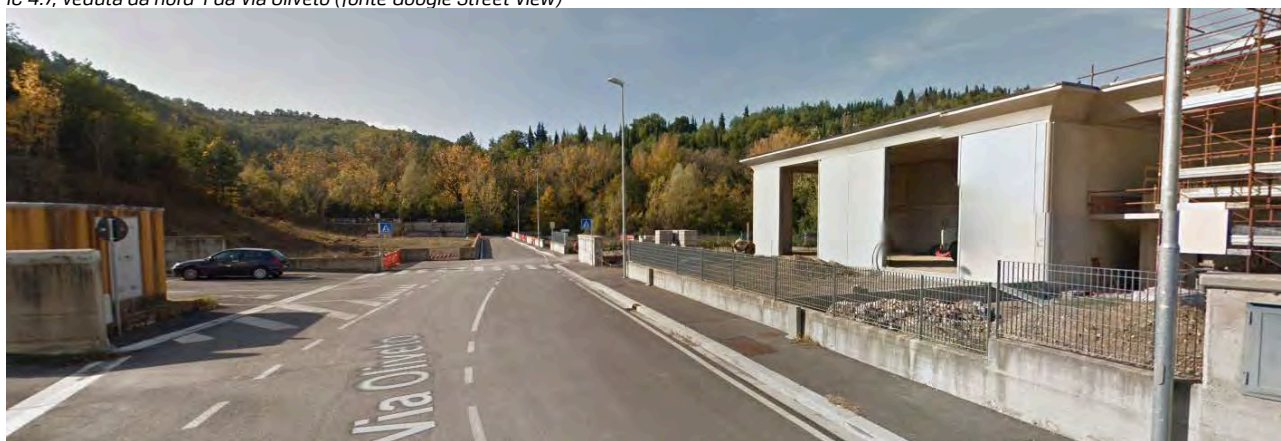
IC 4.7, veduta da nord-2 da Via Oliveto (fonte Google Street View)
