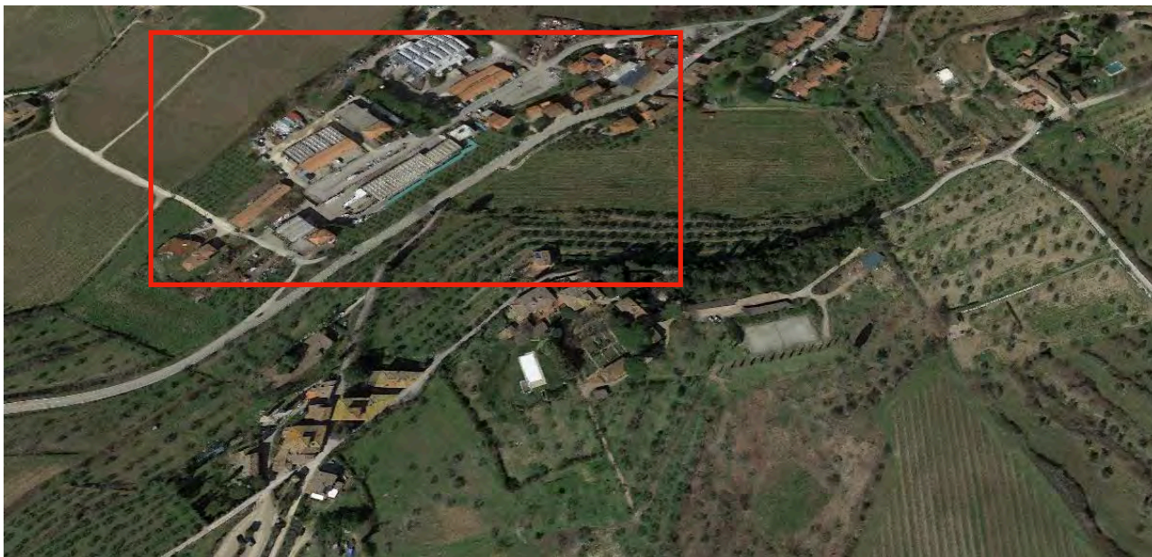
IC 7.2, veduta obliqua dell'area di intervento da sud (fonte Google Street View)
