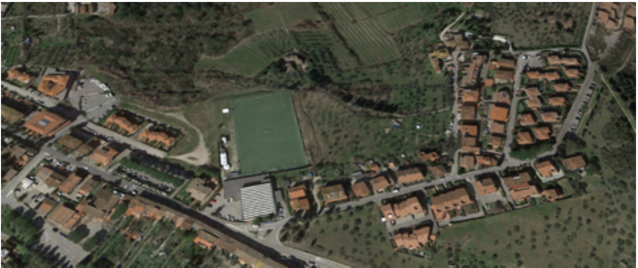
PA 3.05, veduta obliqua dell'area di intervento da sud
