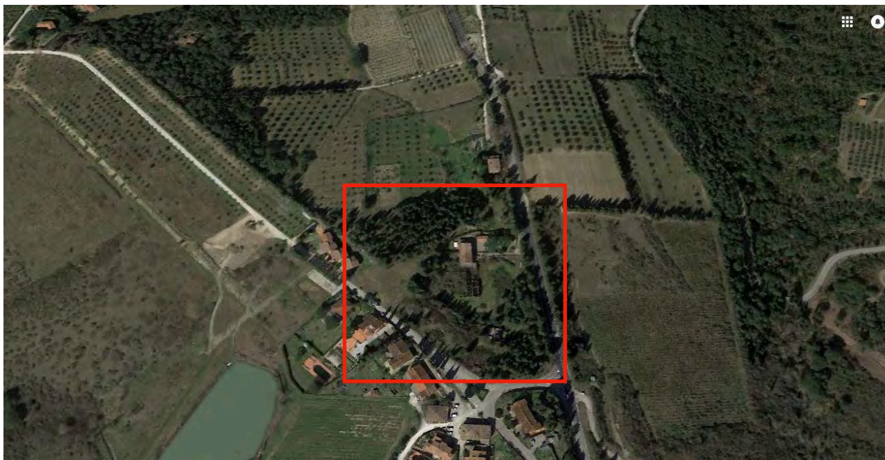
PA 3.6, veduta obliqua dell'area di intervento da sud (fonte Google Street View)
