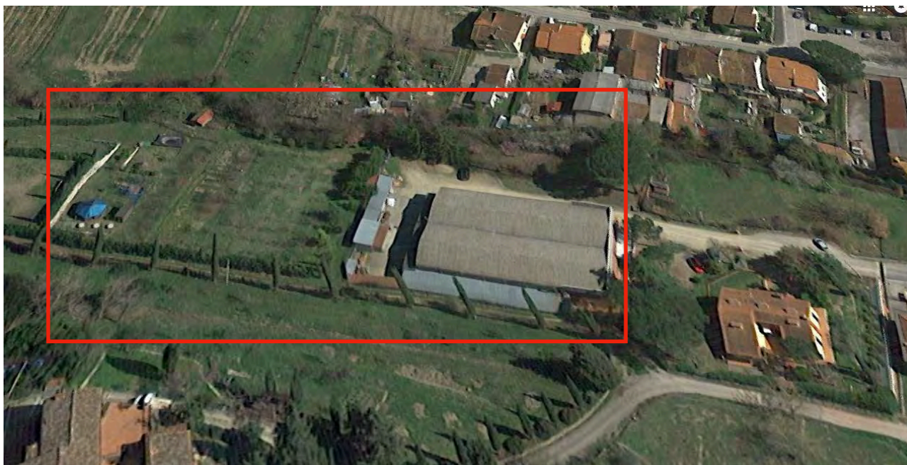
PA 4.1, veduta dell'area di intervento da via di Palaia (fonte Google Street View)
